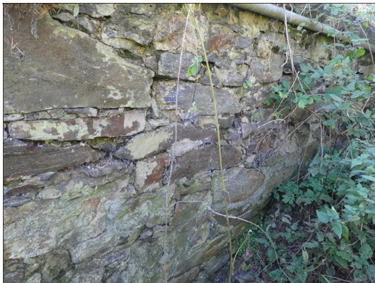
vypadané spárování n akřidle.
