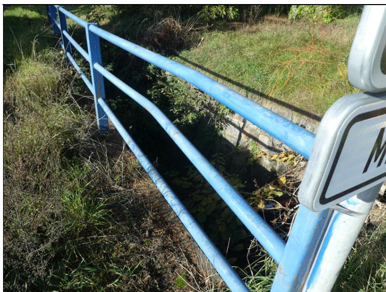
Deformované zábradlí.
