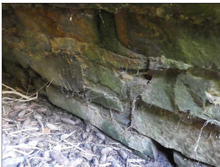
degradace spárování v patě klenby.
